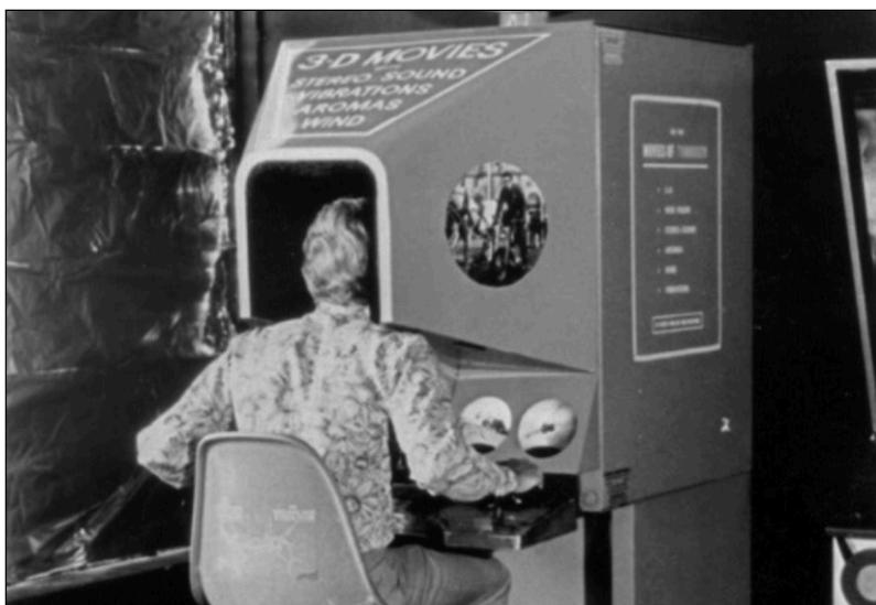
Figura 2 – Sensorama: equipamento projetado por Heilig (HEILIG, 1962)
